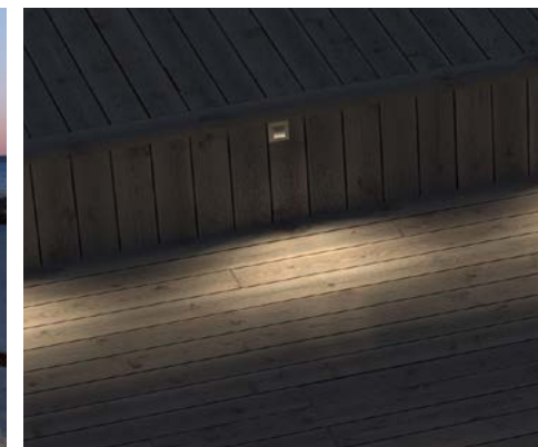
Figur 301. Belysning i träplint längs kajkant. Bildkälla: AFRY/Light bureau
