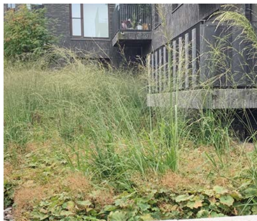
Figur 27. Raingarden, dagvattenhantering på kvartersmark. Bildkälla: Sydväst
