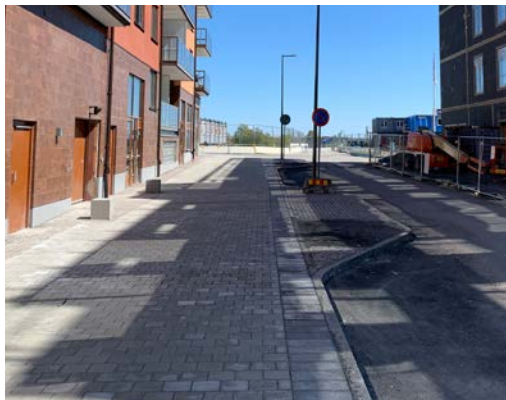
Figur 150. Rationella material som ger en tydlig markering mellan körbanan och trottoar. Bildkälla: Sydväst
