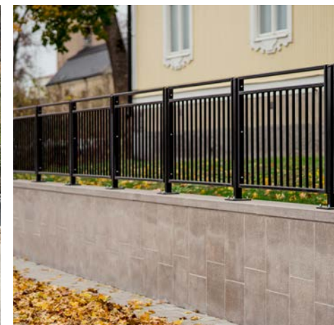
Figur 116. "Standardstaket" framtaget för användning i hamnen. Bildkälla: Norrtälje Hamn
