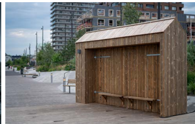
Figur 213. Brons teknikbyggnad som också fungerar som en väderskyddad sittplats. Bildkälla: Sydväst
