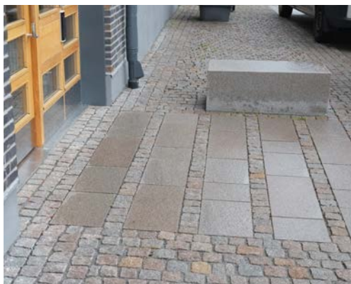
Figur 131. Granithällar och smågatsten mot entré. Bildkälla: Sydväst
