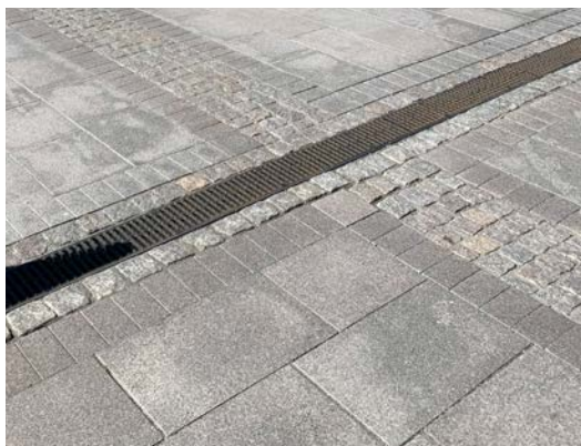
Figur 251. Linjeavvattning Aco-drain. Bildkälla: Sydväst
