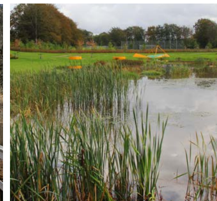
Figur 360. Öppet dagvattensystem för fördröjning och rening av dagvatten. Bildkälla: Sydväst
