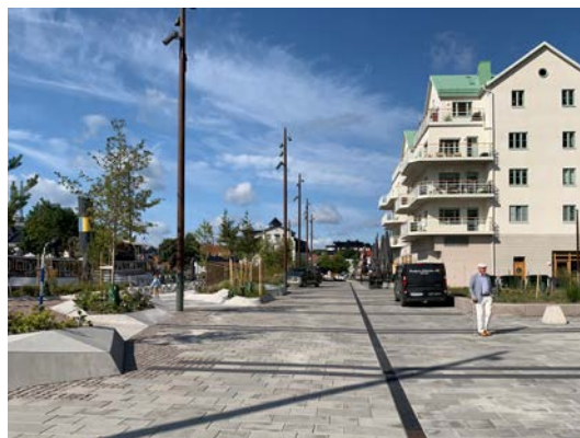
Figur 197. Hamnpromenadens kommunikationsstråk med linjeavvattning som ledstråk. Bildkälla: Sydväst
