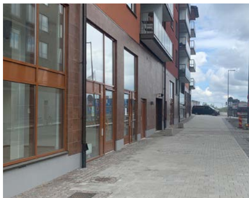
Figur 145. Materialvalen är enkla och rationella och bär ett släktskap med övrig materialpalett. Bildkälla: Sydväst
