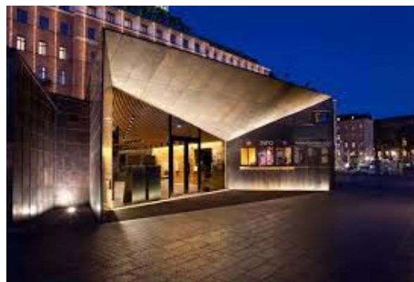
Figur 136. Integrerat ljus som framhäver delar av arkitekturen. Bildkälla: Light Bureau (AFRY)
