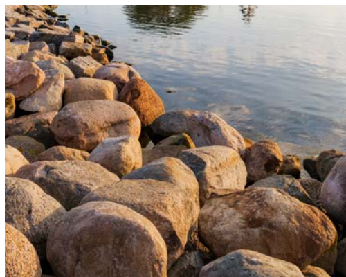
Figur 363. Erosionsskydd i form av stenskoning Bildkälla: Sydväst
