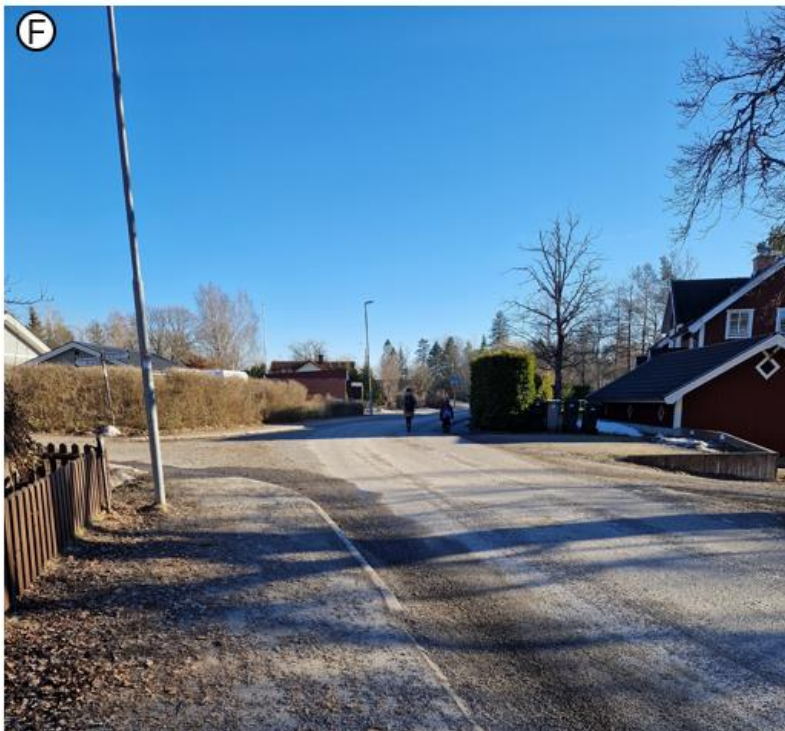
Figur 12. Häck på höger sida vägen skymmer sikten för trafik i riktning mot väg 76. Kurva i kombination med häcken skymmer gångtrafikanter som går på höger sida i riktning mot väg 76. Bild från platsbesök 2024-03-07
