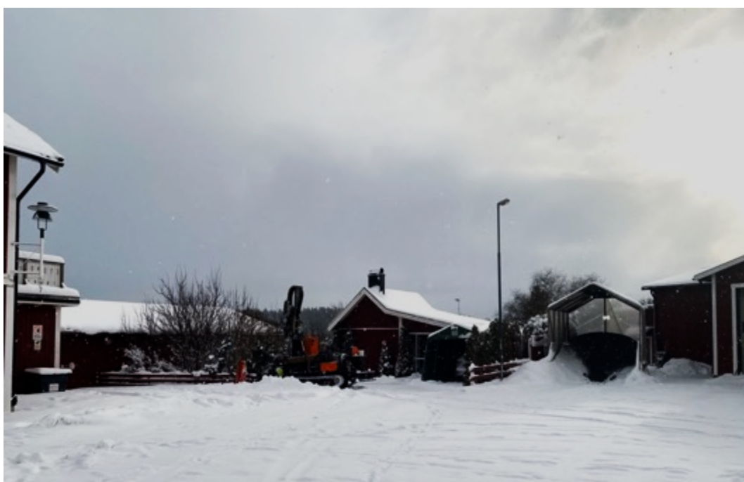
Skruvprovtagning med borrhvagn på Stjärnan 8 och 24 i februari 2021.
