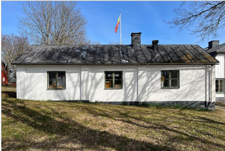
Den södra flygeln ligger på den plats där 1600-talets huvudbyggnad låg. Möjligen är den en av de ursprungliga byggnaderna som flyttades och anpassades till den nya herrgården på 1780-talet. Dess uppbyggnad av liggande reverterat timmer är en källa till kunskap om äldre material och teknik .
