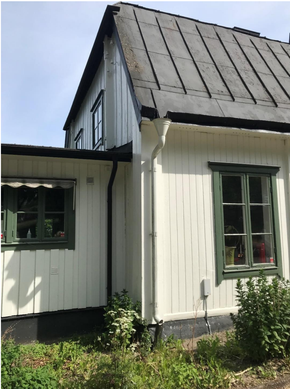
Figur 3 – Huvudbyggnadens tak avvattnas med stuprör och avrinner diffust på markytan där det kan infiltrera.
