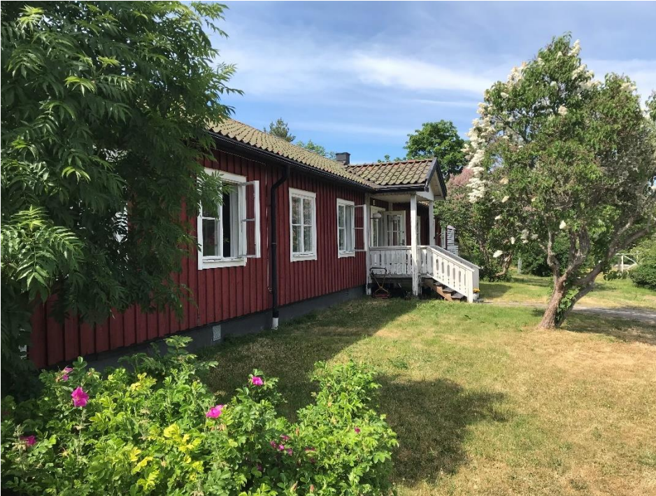
Figur 4 – Exempel på byggnad vars tak avvattnas till ledning under mark. Det är idag inte känt vart vattnet leds vidare.
