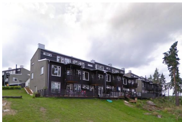
Figur 43. Suterränghus med uteplats mot skogen, Vistaberg. Foto WSP.
