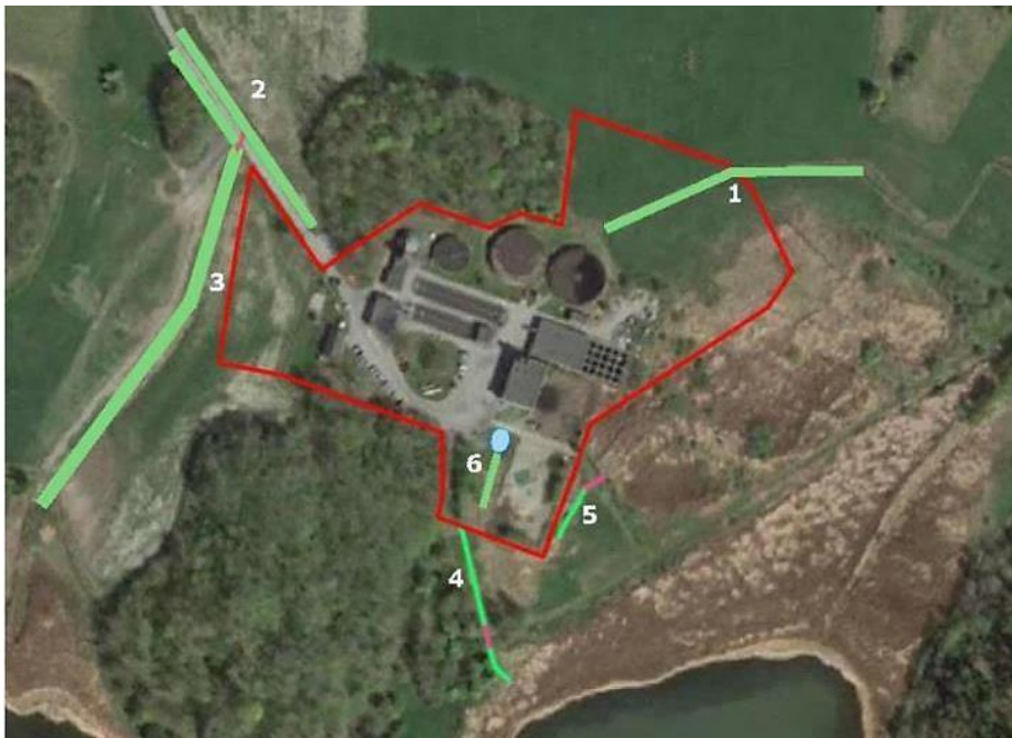
Figur 28: Befintliga diken 1–6 (grönmarkerad linje) inom och i närhet till Lindholmens ARV. Område med dagvattendamm markeras med blå oval (Ramboll, 2023).
