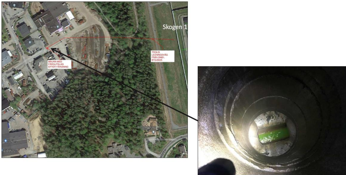
Figur 24. Bilder över markavvattningsföretagets ledning samt brunn med färgat vatten. Bildkälla: Bylero utredningsrapport 2022-01-28.
