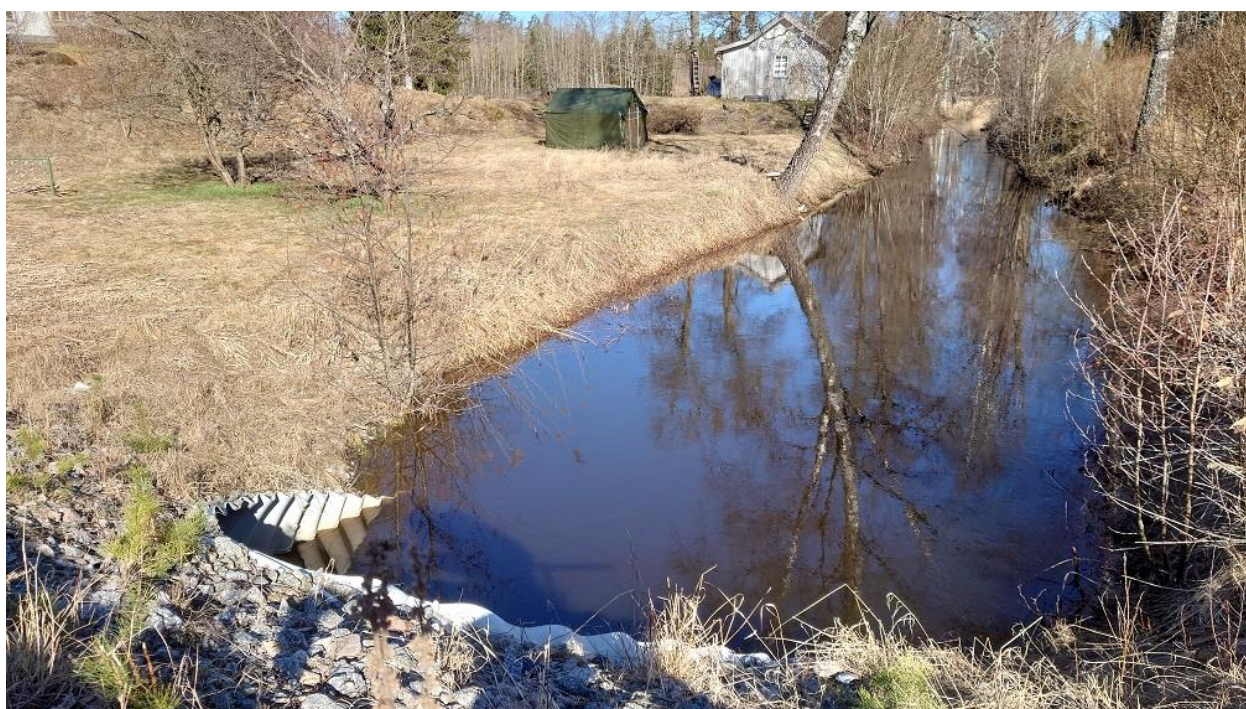
Figur 19. Provtagningslokalen i Bergshamraån ligger vid en lugnflytande sträcka precis nedströms en vägtrumma. Längre nedströms provtagningslokalen är Bergshamraån slingrande och bitvis strömmande.
