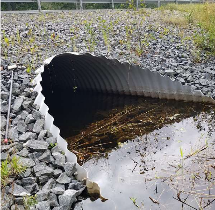
Figur 18. Provtagningslokalen i Bergshamraån ligger vid en lugnflytande sträcka precis nedströms en vägtrumma. Längre nedströms provtagningslokalen är Bergshamraån slingrande och bitvis strömmande.
