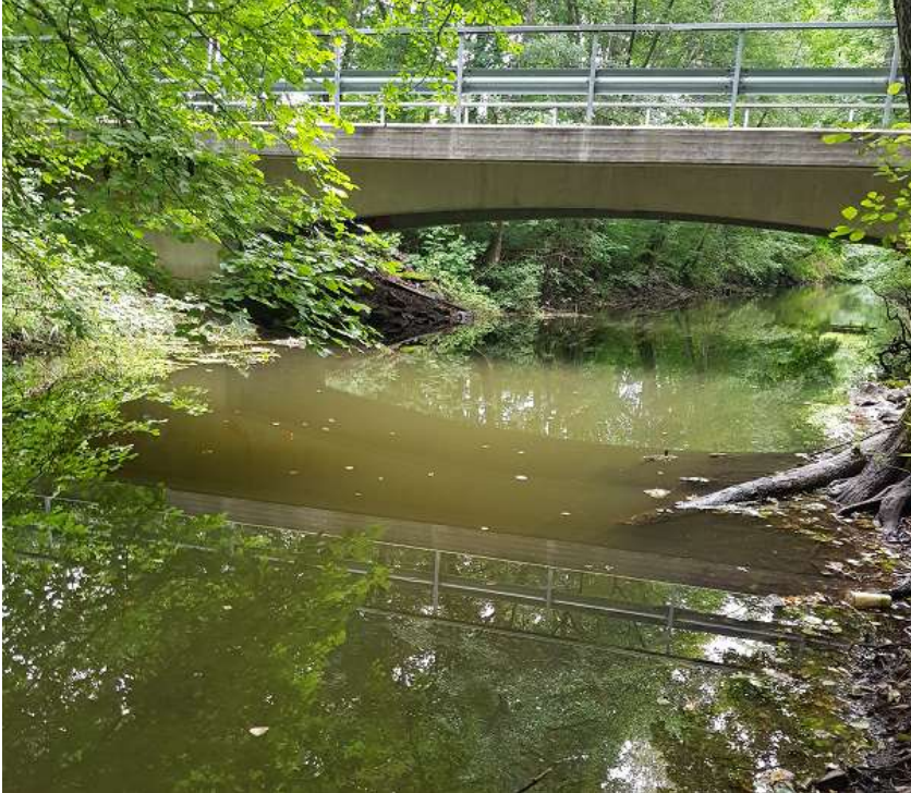
Figur 20. Provtagningslokalen i Broströmmen är belägen nedströms en vägbro en dryg kilometer innan vattensystemet mynnar i Norrtäljeviken. Vattendraget har här strömmande karaktär och erbjuder fina lekbottnar för havsöring.
