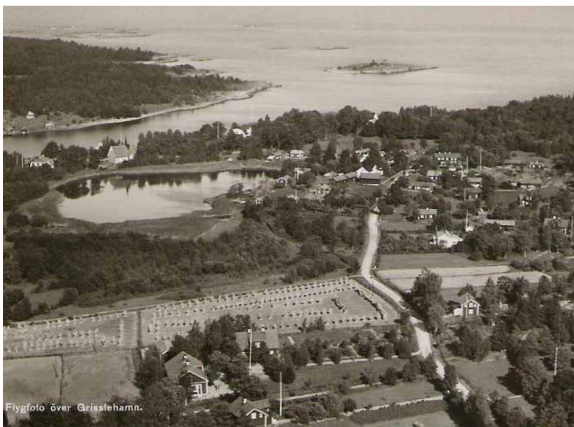
Flygbild över Grisslehamn från väster med hamninloppet och Loskäret i bakgrunden. Landsvägen som slingrar sig genom samhället från väster fram till småbåtshamnen som ligger utanför bilden till vänster om det ljusa kapellet.
