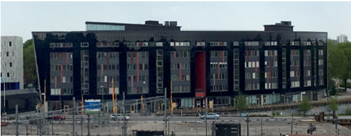
Den svarta fasaden är integrerade solceller
