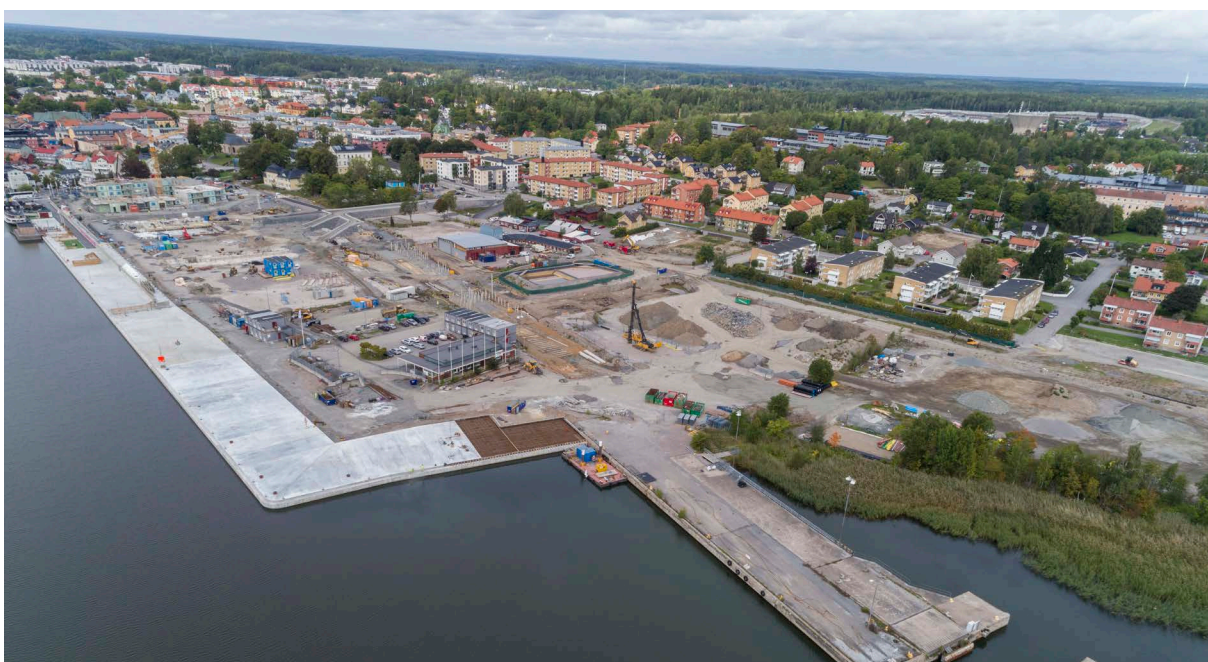
FIGUR 30. FLYGBILD NORRTÄLJE HAMN SEPTEMBER 2017. OMRÅDET KOMMER VARA EN BYGGARBETSPLATS MÅNGA ÅR FRAM I TIDEN.
